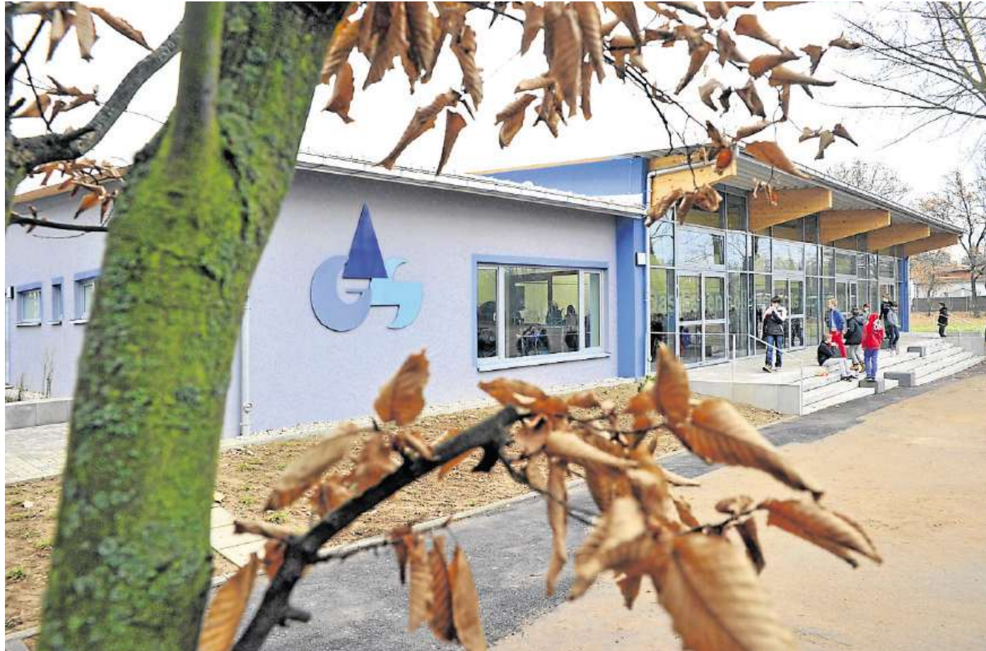
Mit großer Glasfassade öffnet sich die neue Mensa der IGS Kurt Schumacher zum Pausenhof hin.
